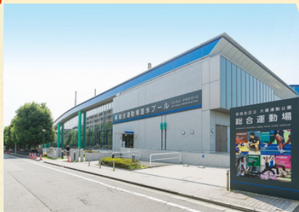
世田谷区立総合運動場 温水プール
